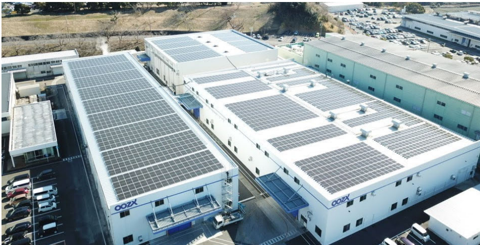
静岡工場の太陽光発電パネル
