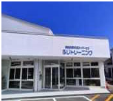
ふじトレーニングの建屋外観
